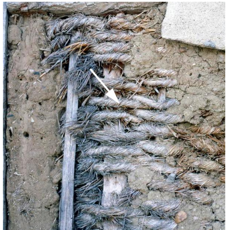
Illustration 21: Détail. De l'illustration 20- La paille est torsadée directement ou après trempage dans une barbotine de terre, puis elle est tressée sur la première trame. (Choplain Roger; Maston Roland)
