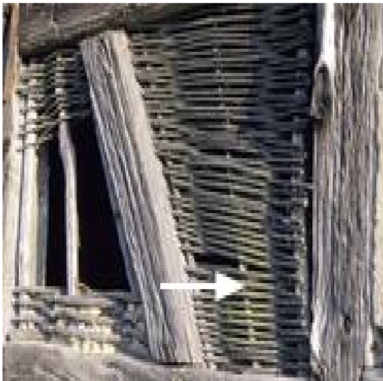
Illustration 22: Clayonnage composé de palaçons verticaux en première trame (Fig. 9) et de baguettes horizontales en 2e trame. (© Médiathèque de l'architecture et du patrimoine (Centre de recherche des monuments historiques - CRMH) diffusion RMN, Charles Hurault)
