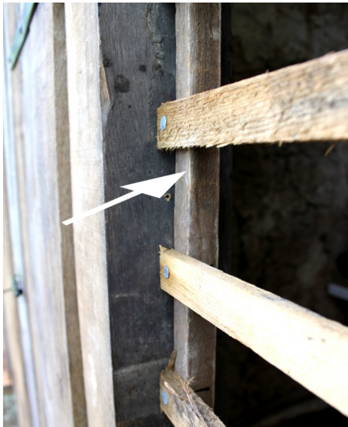
Illustration 13: Contre-latte visible avant la pose du mélange Normandie (Yan Minne)
