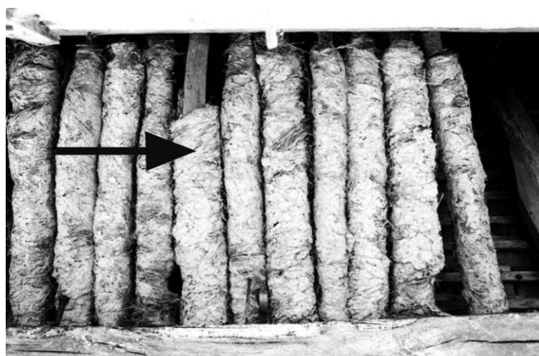
Illustration 7: Andouilles ou quenouilles, inachevées, non serrées les unes aux autres, laissant entrapercevoir le palançon. (© Région Centre-Val de Loire, Inventaire général, Robert Malnoury)
