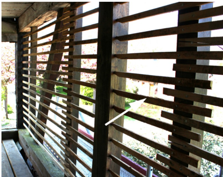
Illustration 16: Lattage formant lattis par endroit (Yan Minne)
