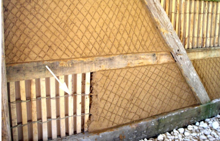
Illustration 19: un clayonnage composé de palançons verticaux en première trame et de liens d'osier en deuxième trame (Aurélie Le Pape)
