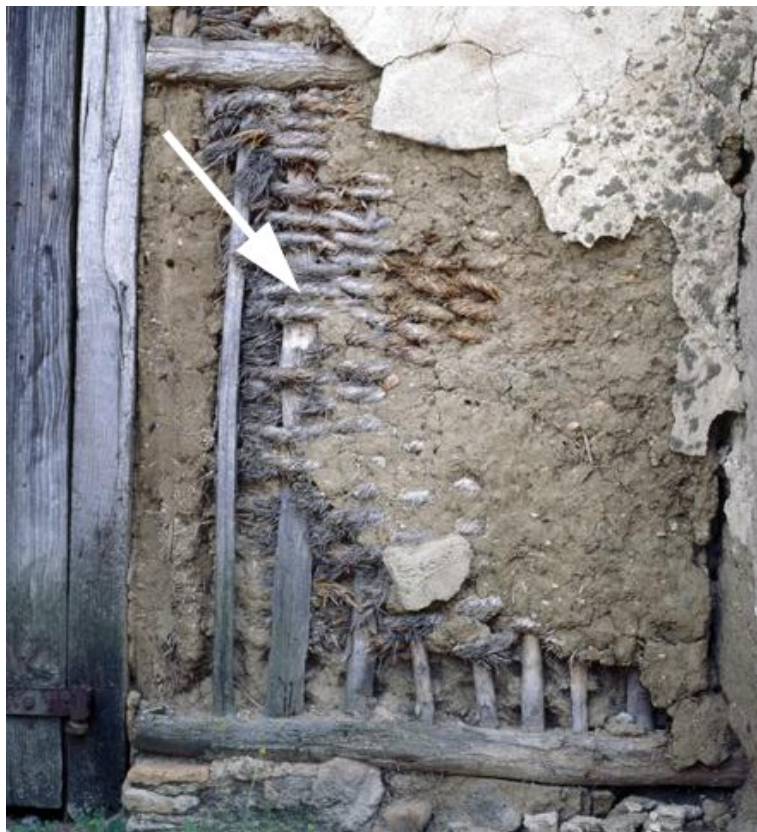
Illustration 20: Clayonnage composé de palançons verticaux en première trame de cordes de paille en seconde trame. (Choplain Roger; Maston Roland)
