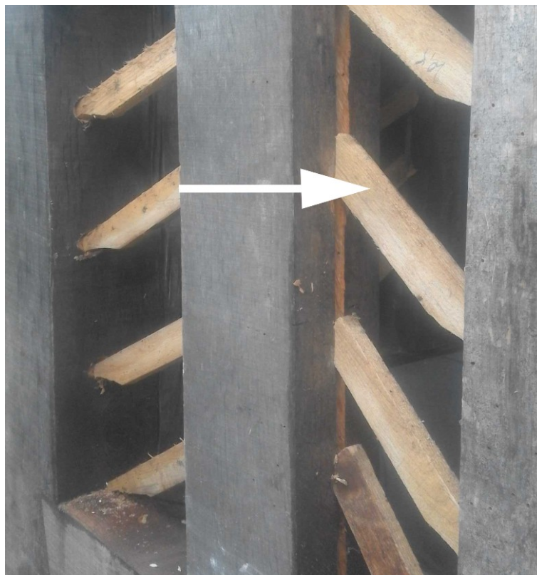
Illustration 11: une éclisse entre deux colombes de trame étroite avant la pose du mélange. (Yan Minne)
