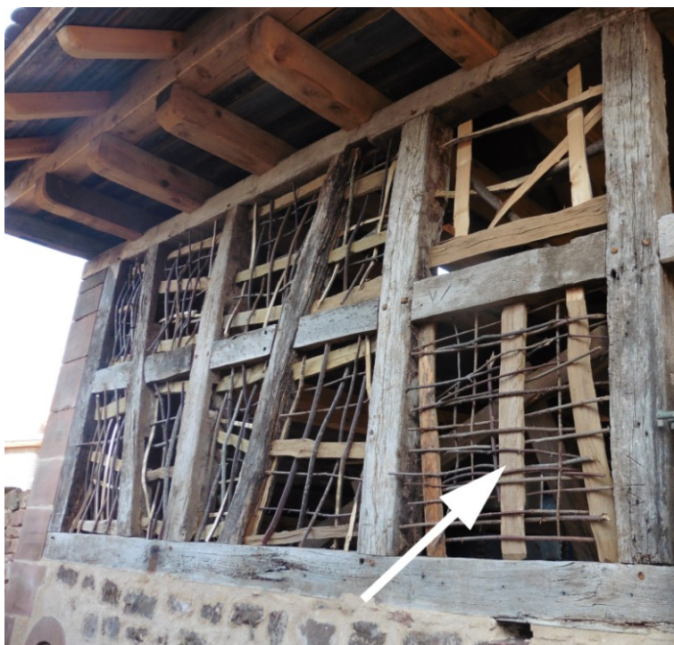
Illustration 23: Clayonnage composé de 3 palaçons verticaux en première trame et de baguettes croisées en 2e trame en Alsace. (Sophie Popot)
